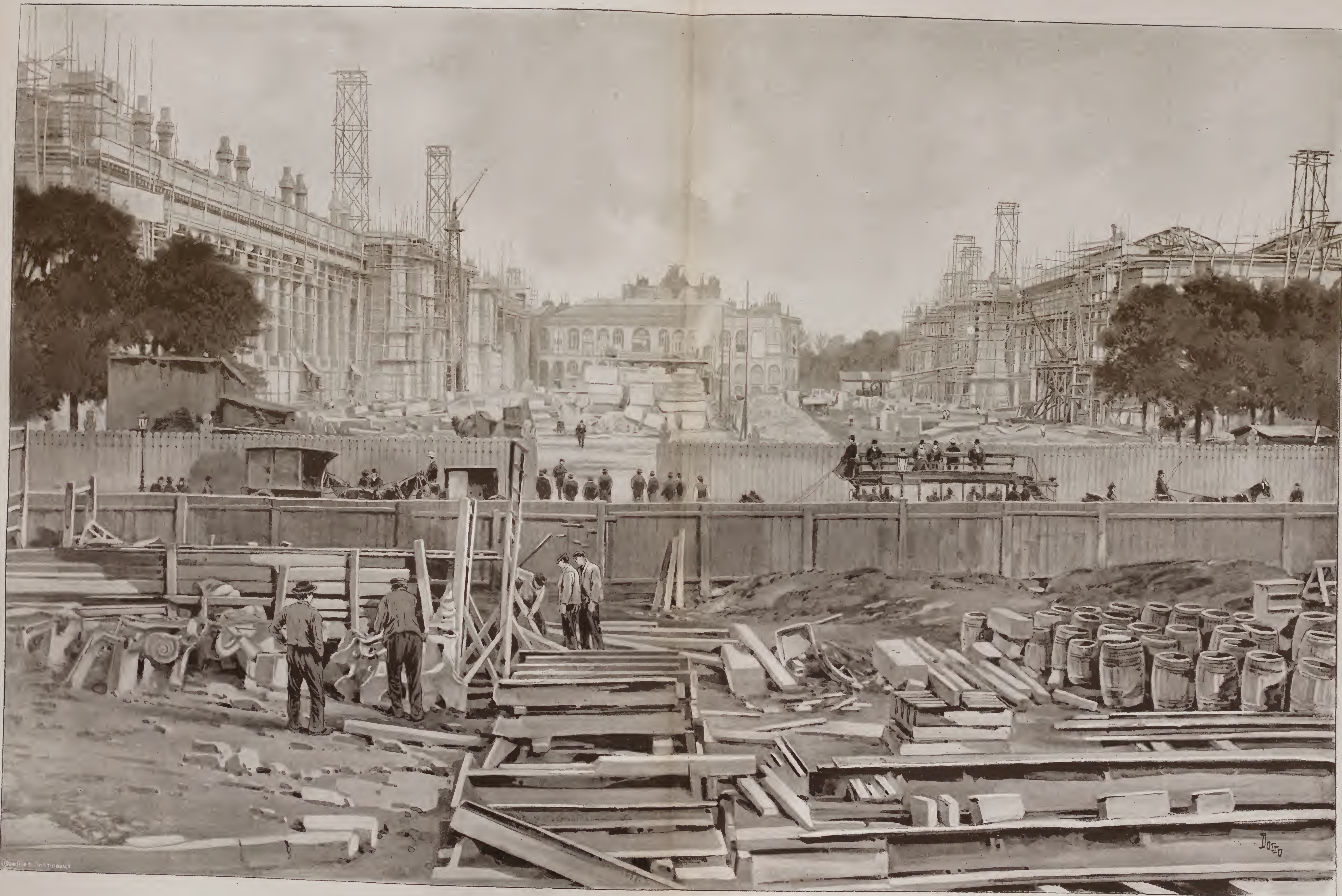
LES CHANTIERS DE LA NOUVELLE AVENUE DES CHAMPS-ÉLYSÉES. (Fin Mai 1899.)
